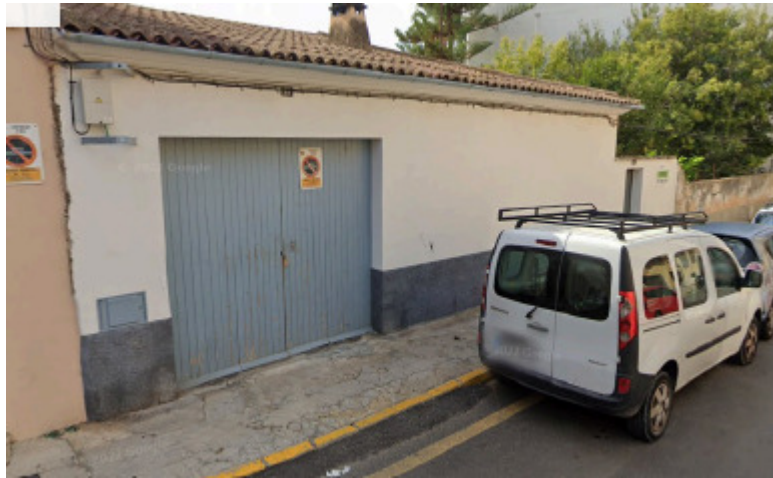
Imatge 3. Vista de la parcel·la objecte de la present modificació puntual.
