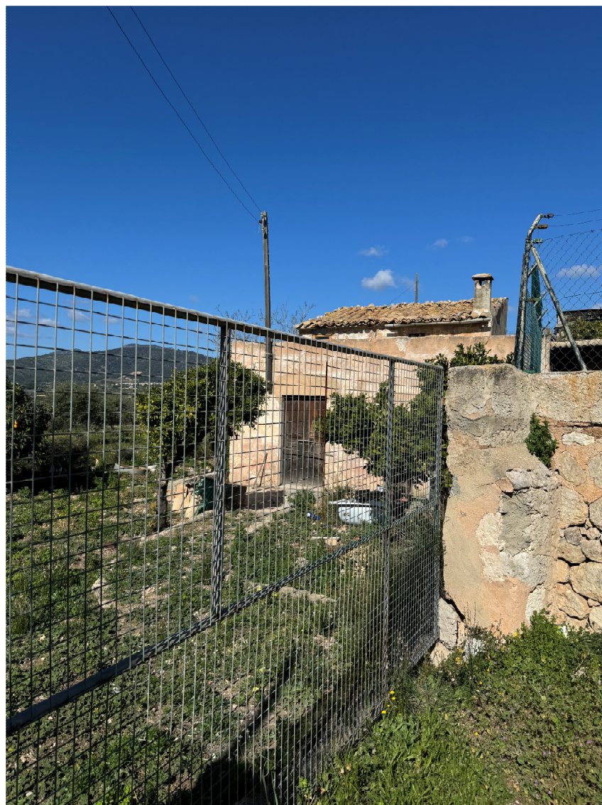
Imatge 10. Imatge de la parcel·la edificada i de l'estat de conservació de l'edificació existent
