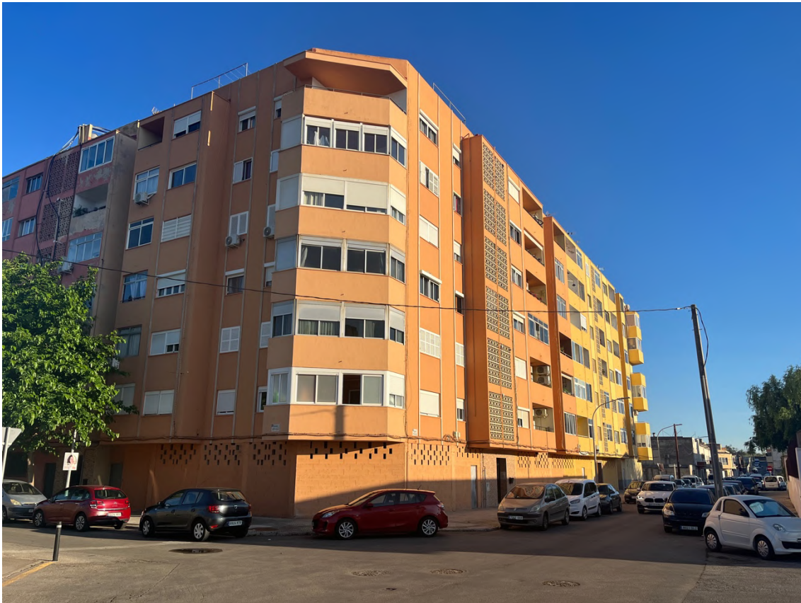
Imatge 6 . Façana de l'edifici. Carrer Mostassaf, carrer Eivissa.
