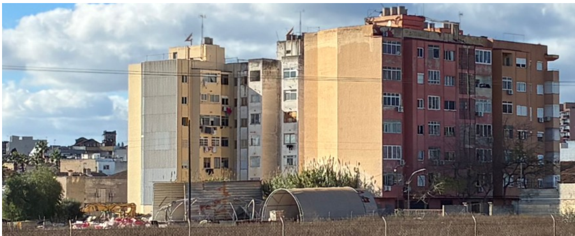
Imatge 3. Façana posterior edifici carrer Mostassaf
