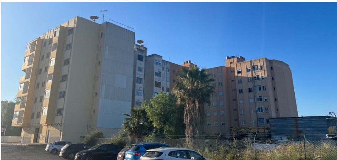
Imatge 3 . Mitgera de l'edifici existent amb referència cadastral 3269508DD9937S
