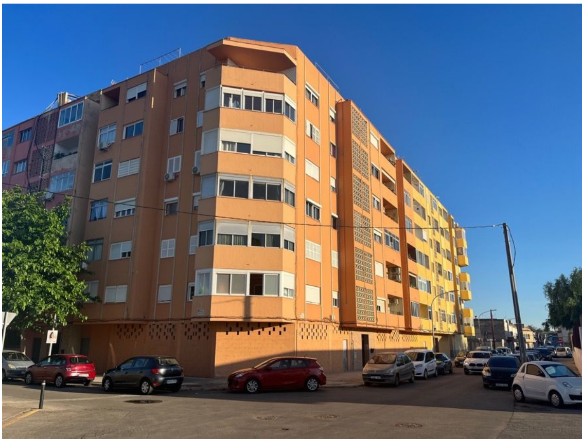
Imatge 4 . Façana de l'edifici. Carrer Mostassaf, carrer Eivissa.
